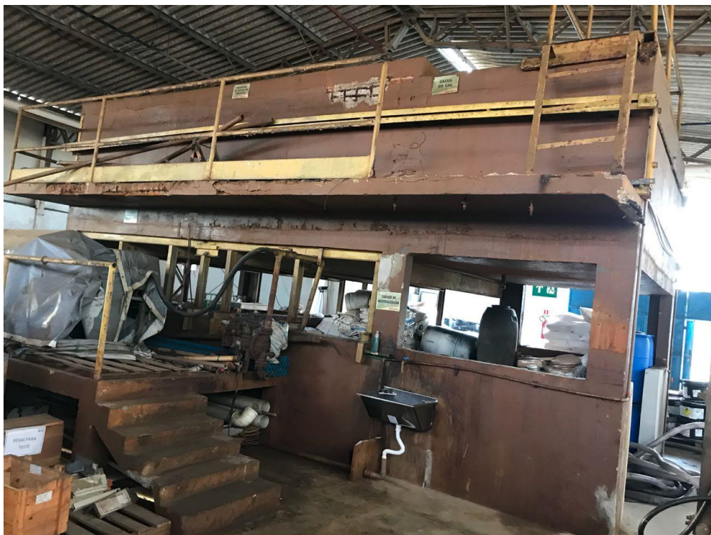
Figura 9 – Tanque em concreto armado onde era armazenado ácido clorídrico.
