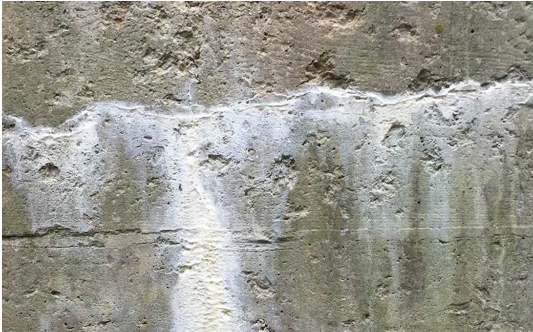
Figura 3 – Processo de Lixiviação em estruturas de concreto
